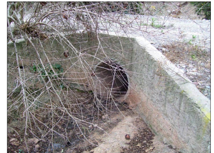
F2 Sección obra de drenaje transversa aguas arriba
