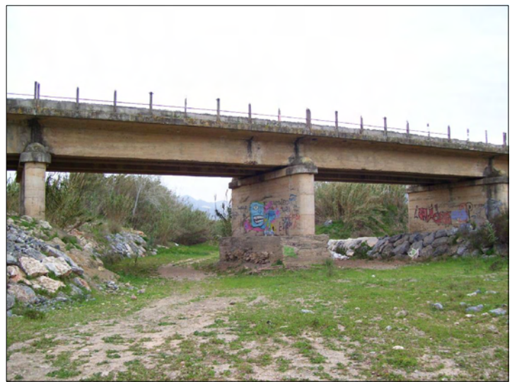
F4 Puente aguas arriba
