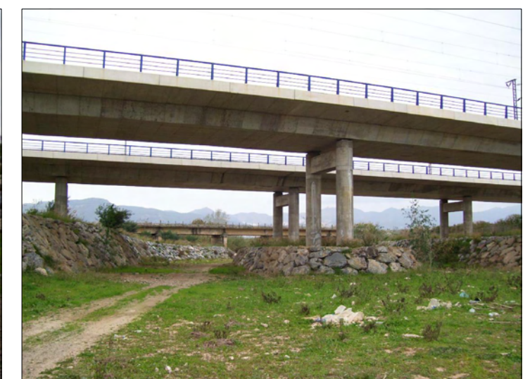
F4 Puente aguas arriba
