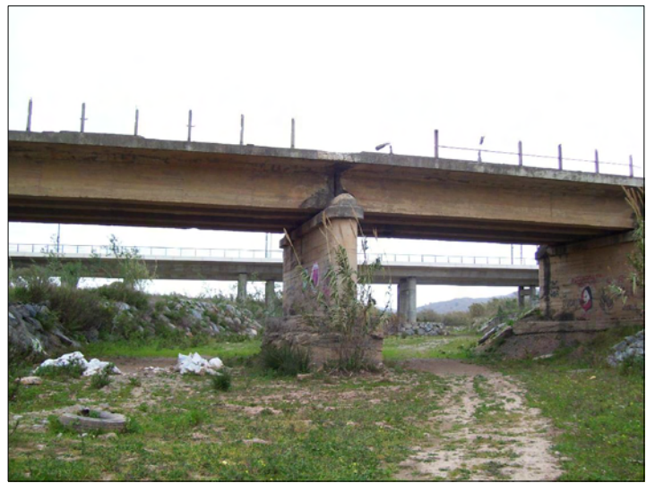
F2 Puente aguas abajo
