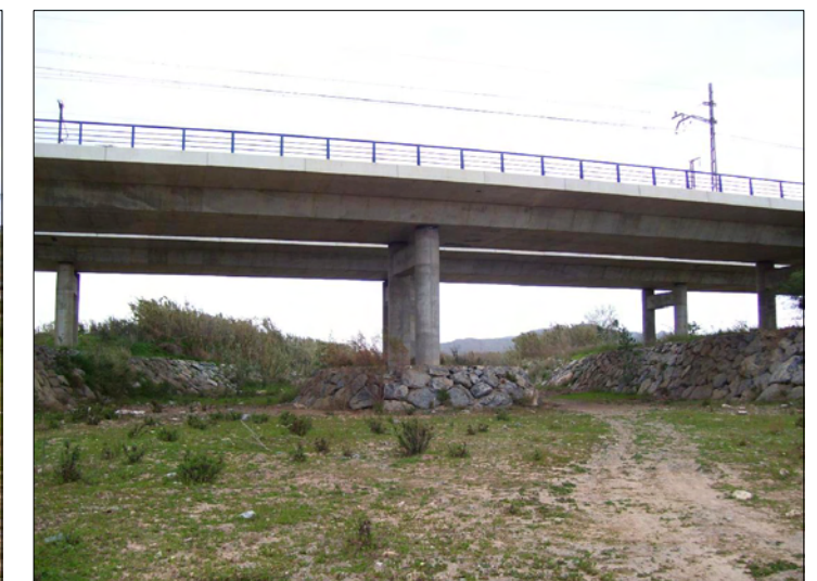
F2 Puente aguas abajo
