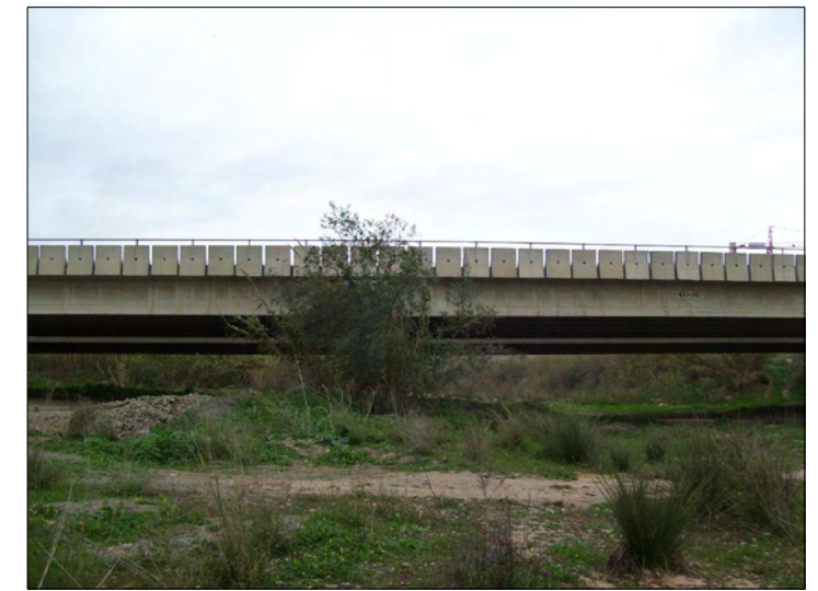
F2 Puente aguas abajo
