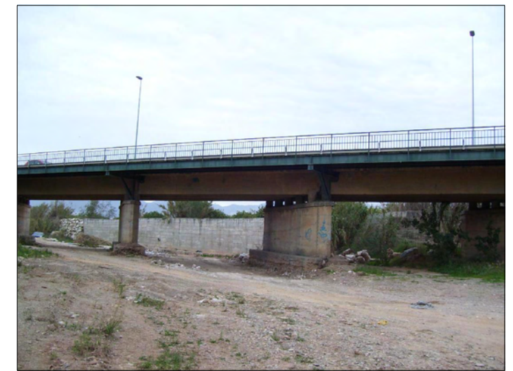
F4 Puente aguas arriba
