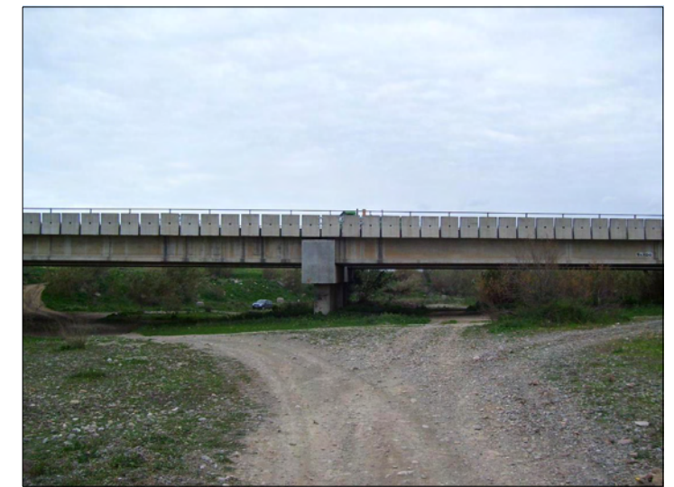
F4 Puente aguas arriba
