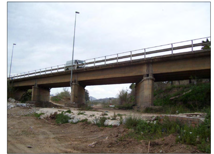
F2 Puente aguas abajo
